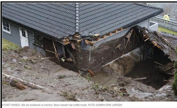
STORT SKRED: Slik ser jordskred ut ovenfra. Store masser har truffet huset. FOTO: BJØRN ERIK LARSEN
