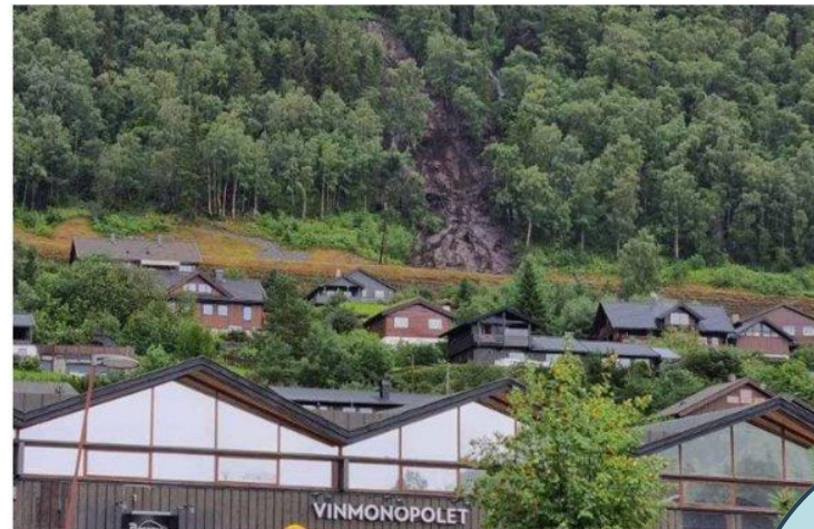
Raset i Lom stoppa i rasvullen som stod ferdig i 2020. Foto: Reidar Kjæstad
