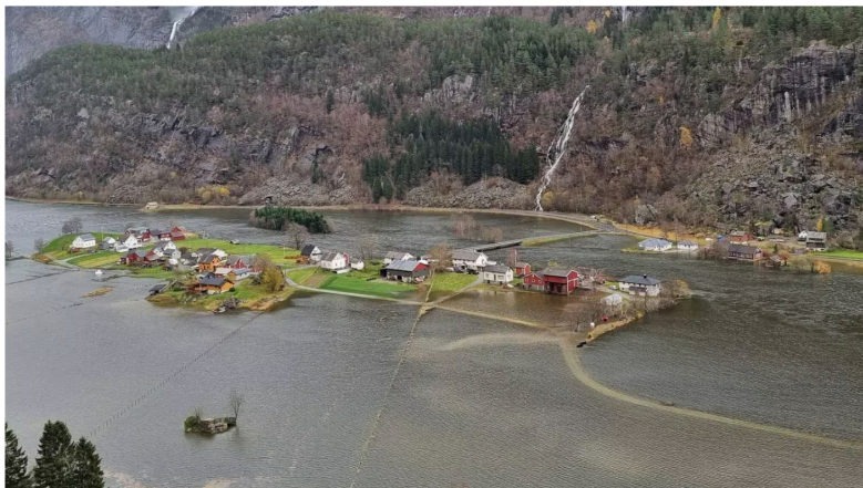
HØYT VANN: Gården til Einar Riise er til høyre i bildet. Vannet står helt opp mot husveggen. FOTO: EINAR RIISE
