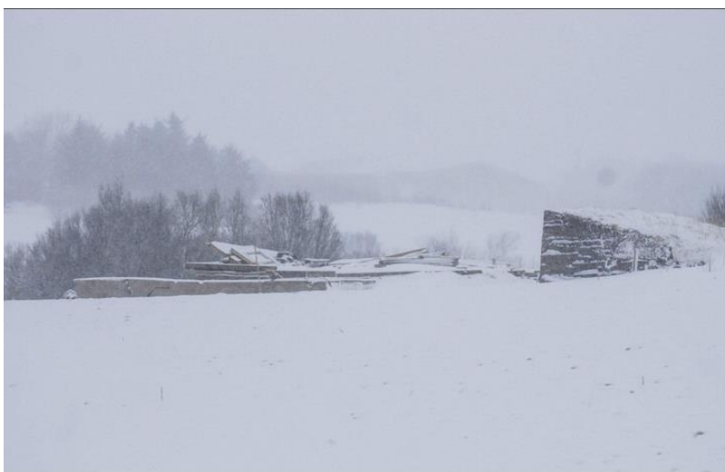
Figur 13: En fjøs i Opdøl med kun muren og låvebrua igjen.
